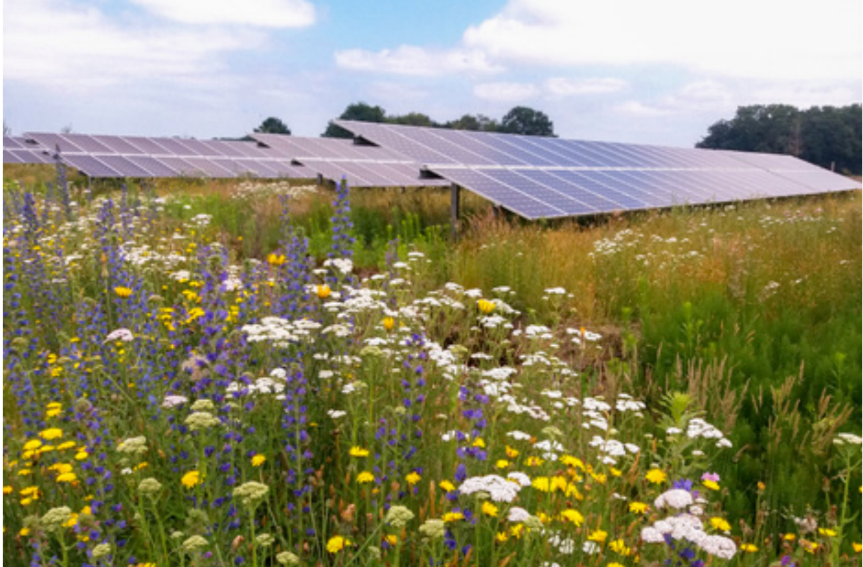
NL Solarpark De Kwekerij Hengelo.
