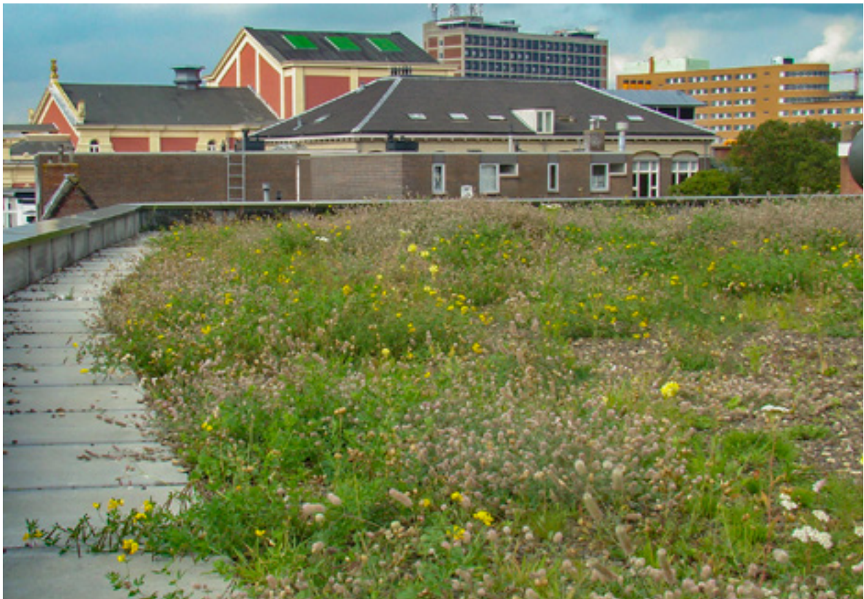
Dakvegetatie Werkmancollege Groningen • Foto: Sicco van der Brug
