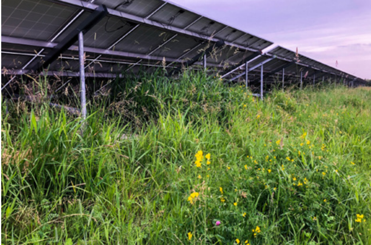
Ecologisch zonnepark bij het Drentse Ubberna.
